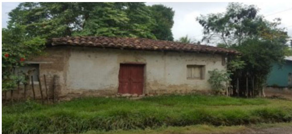
Fig. 1. Vivienda de adobe de Las Marías.
