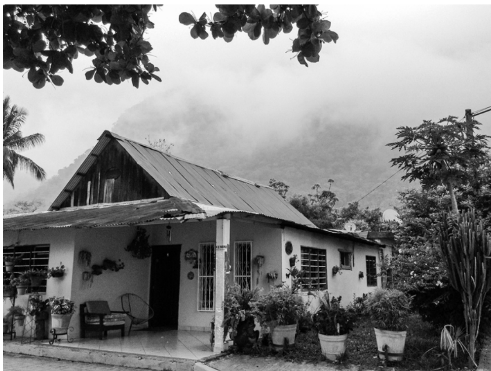
Figura 2. Vivienda ubicada en el pueblo de Santa María Jacatepec. 2015. Autor: Marcos Núñez Núñez
